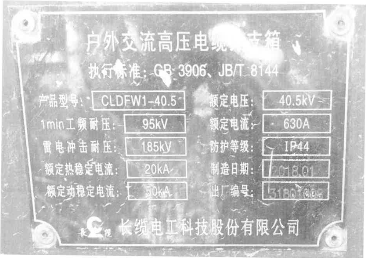
附件二：在用电缆分支箱及铭牌
