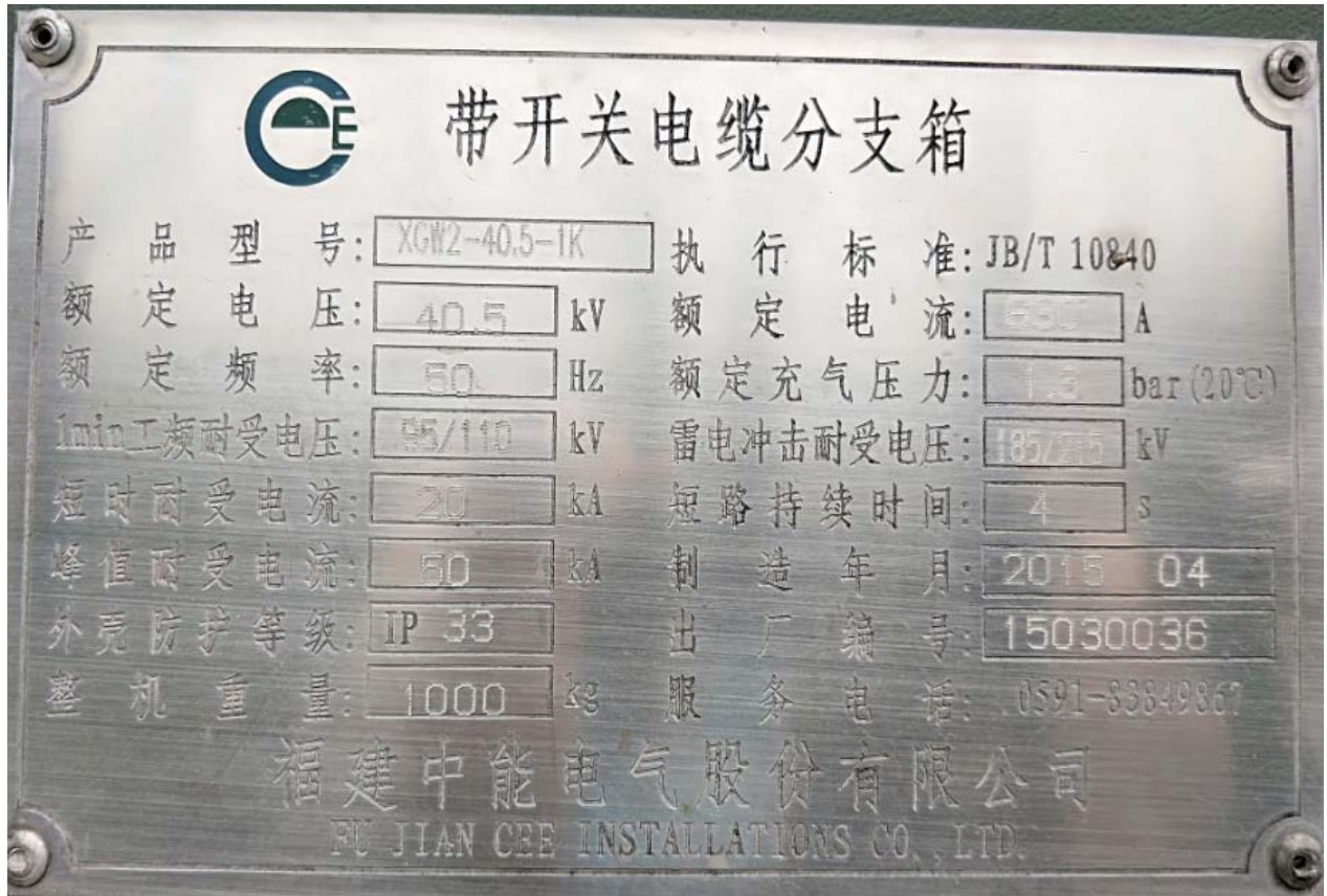
附件二：在用电缆分支箱及铭牌
